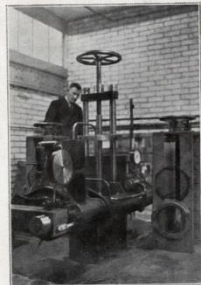
Le dynamomètre auquel est attachée la locomotive. Cet appareil permet d'apprécier des efforts allant jusqu'à 45 tonnes.
