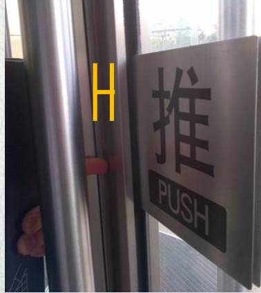
L1 – Exterior Door Leak : Partial Seal
